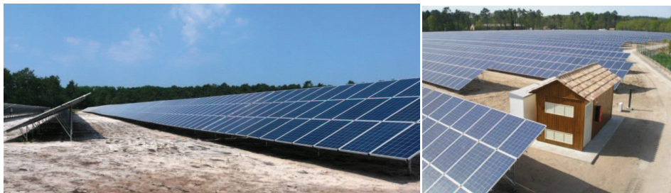
Photo 4 : Centrale photovoltaïque de Sansuère exploitée par JPEE
