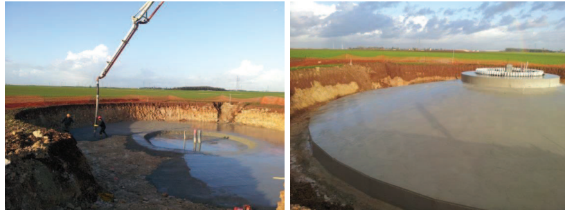
Chantier éolien – Novembre 2013
