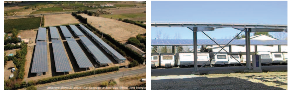
Photo 2 : Ombrières photovoltaïques de Le Bosc exploitées par JPEE
