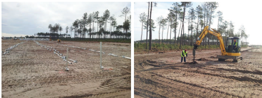
Photo 5 : Chantier de Carcen Ponson – avril 2014
